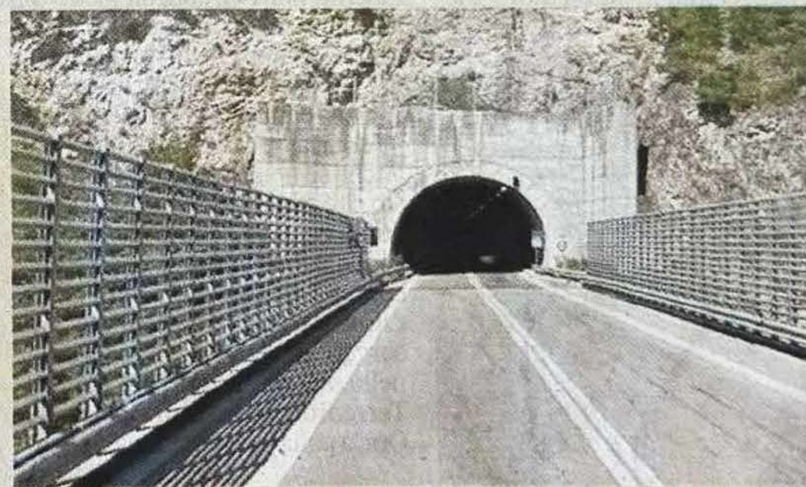
La galleria resterà chiusa fino al 27 ottobre
